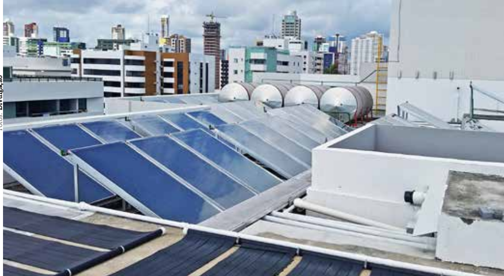
1 Construtora Holanda foi pioneira na aplicação dessa tecnologia, em prédio residencial
